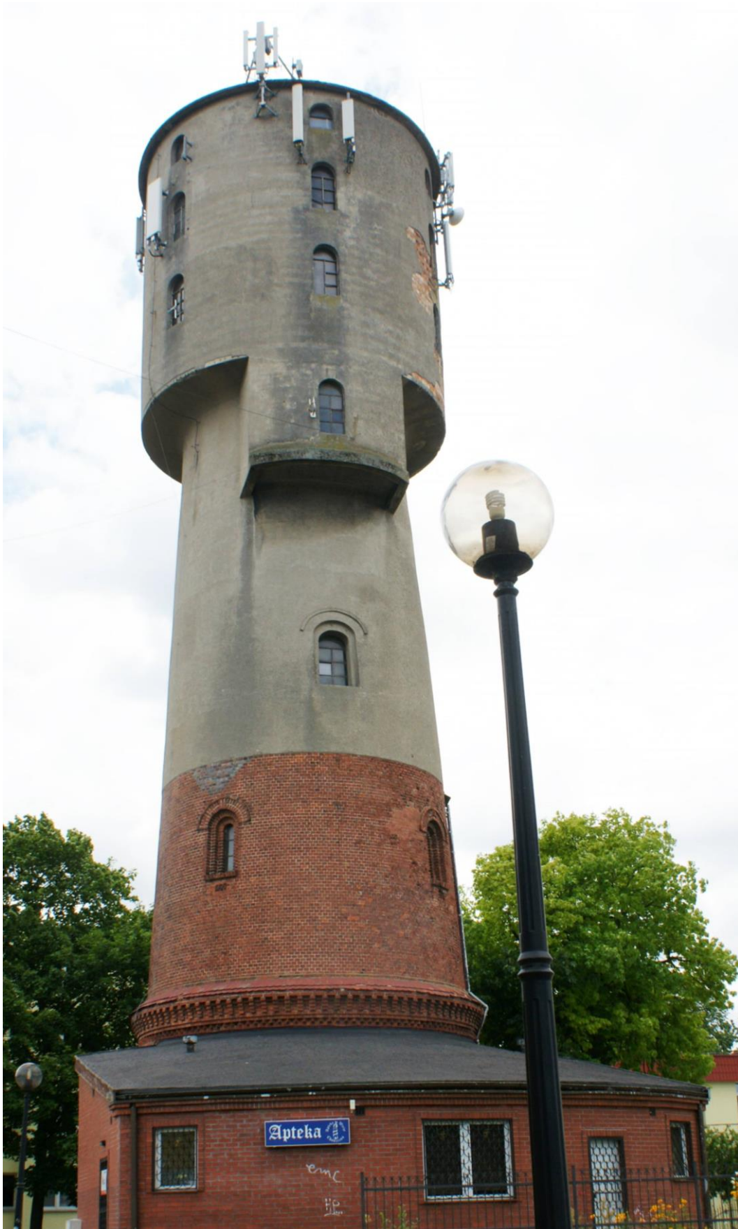
Wieża ciśnień koło szpitala. 13 metrów od dołu stan z 1903, powyżej - stan od 1946 r.
