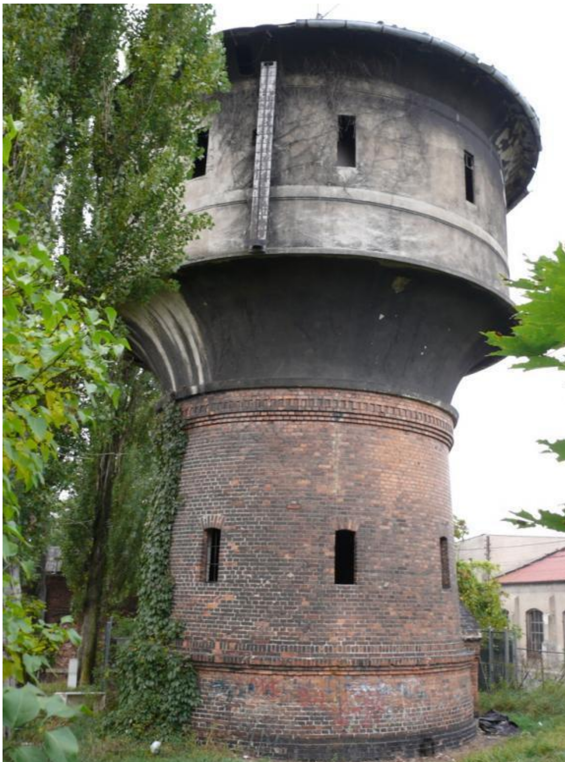
Choszczno. Wieża ciśnień koło dworca kolejowego. Nieczynna od 1945 roku. Stan w 2025 r.
